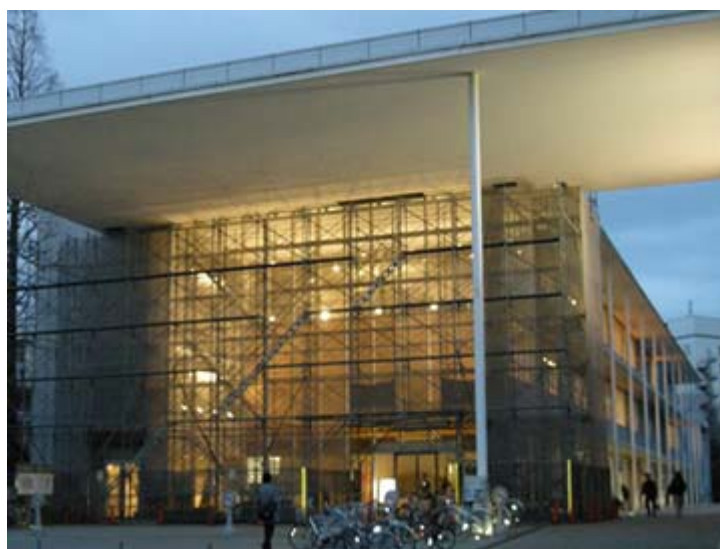
改修中の購買部建物
